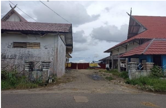
Foto Jalan Masuk Dermaga Pelabuhan Perikanan Kuala Pembuang
