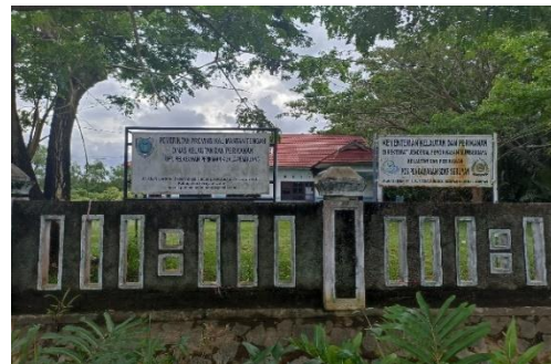
Foto Tampak Depan Kantor Pelabuhan Perikanan Kuala Pembuang
